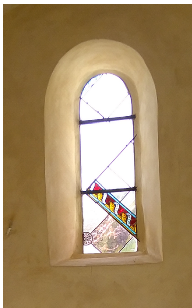
Photo 25 : Vitrail gauche de la façade ouest (créé)
