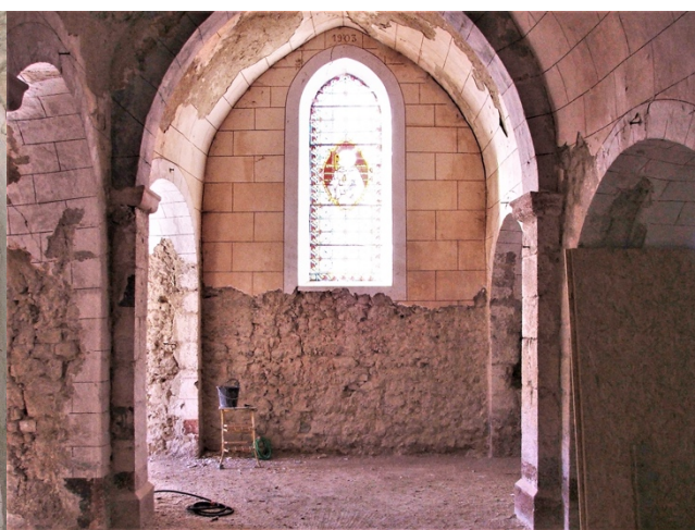
Photo 17 : Vitrail St-Clair en cours de travaux
