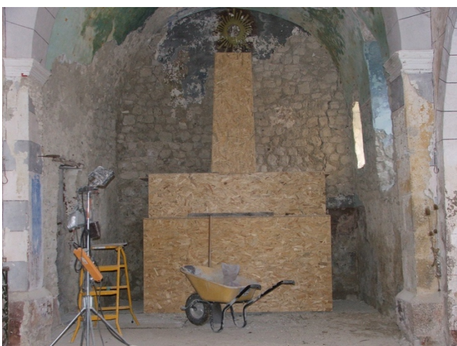
Photo 18 : Maître Autel en cours de travaux
