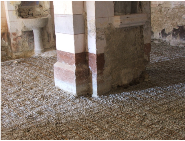
Photo 20 : Sol en cours de travaux
