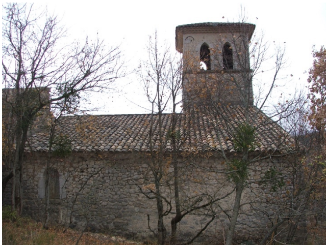
Photo 14 : Façade nord et toit avant
