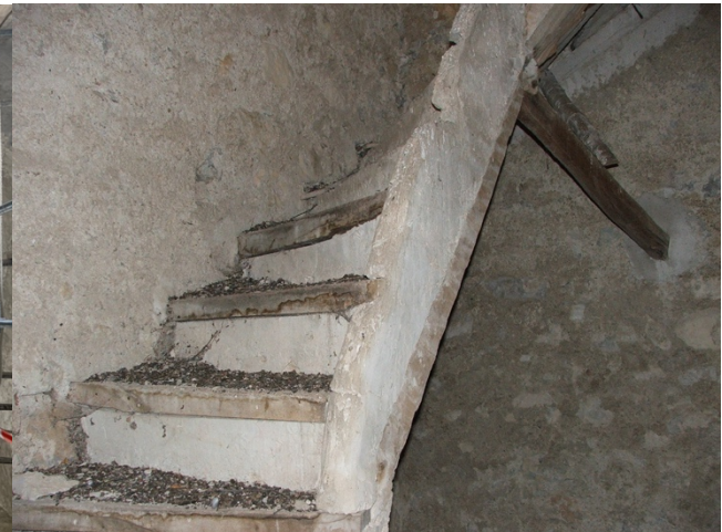
Photo 23 : Escalier d'accès au clocher avant
