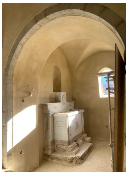
Photo 19 : Autel de la Vierge en cours de travaux
