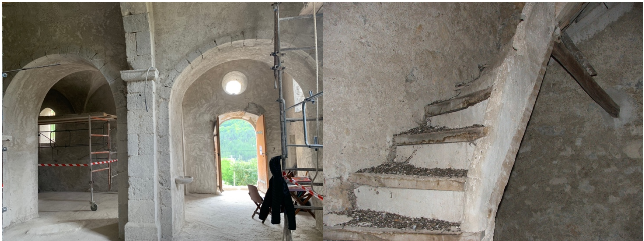
Photo 22 : Porte d'entrée en cours de travaux
