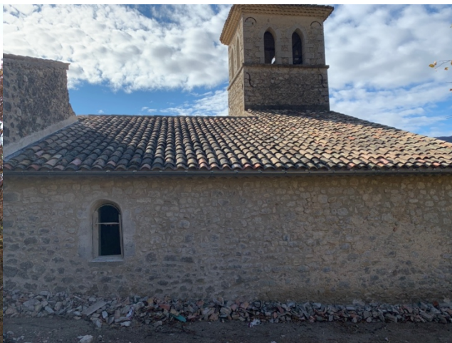
Photo 15 : Façade nord et toit après
