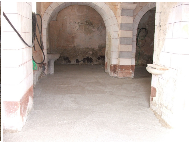
Photo 21 : Sol en cours de travaux
