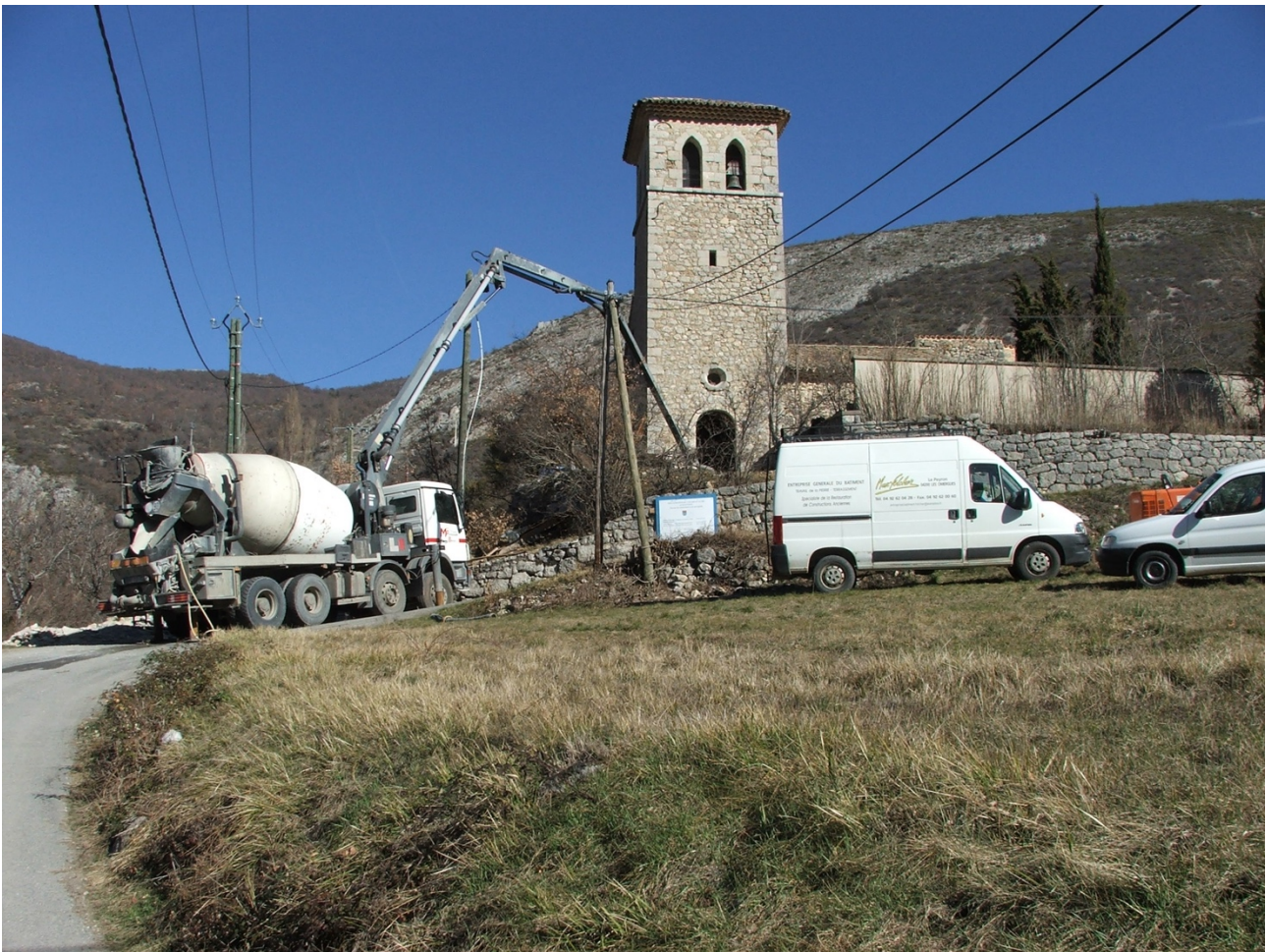
Photo 13 : Chantier vue générale
