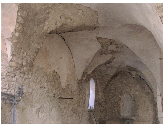
Photo 16 : Intérieur en cours de travaux
